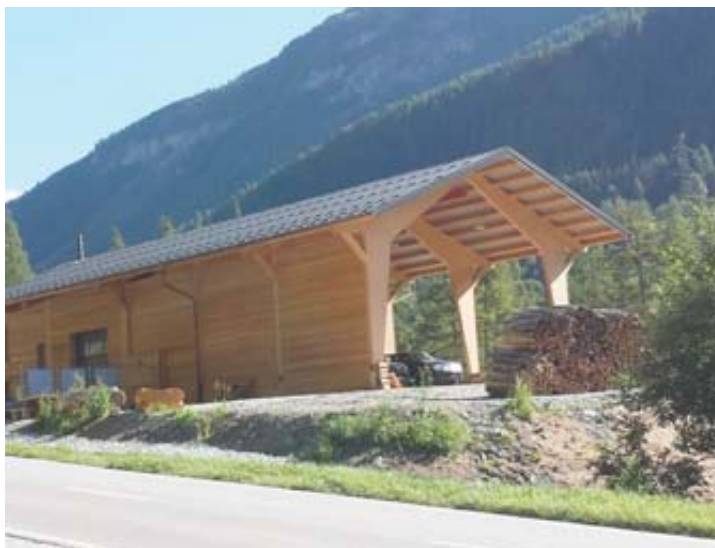
C'est une construction en mélèze qui a été choisie. DR
